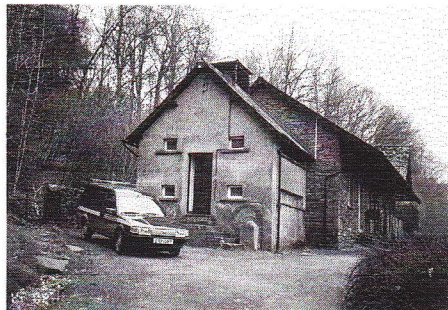
写真1 貯蔵庫 (larder)。手前の白壁の小屋
